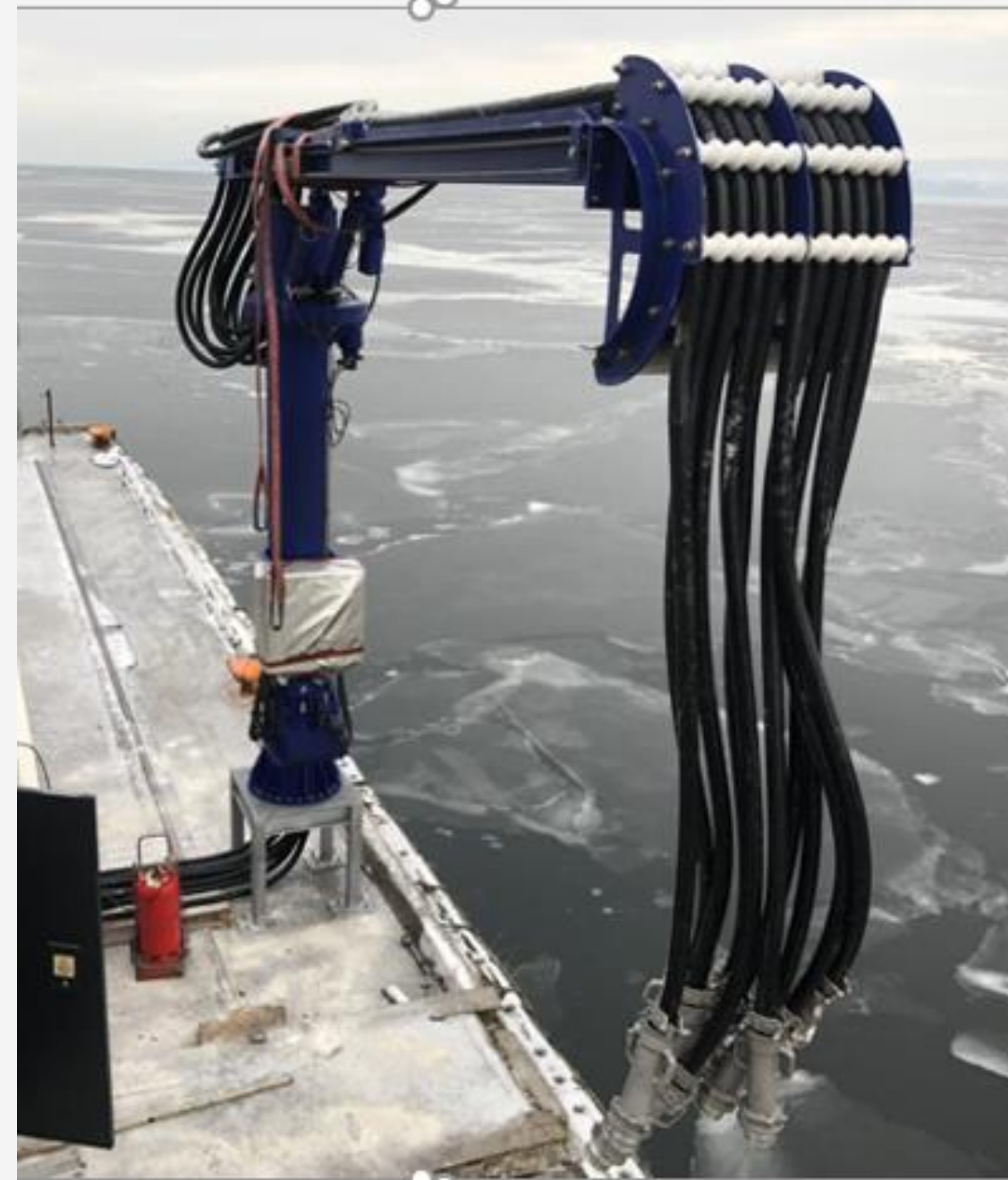
Landstrømanlegg Norcem Slemmestad. 2 MW anlegg for utslippsfri lossing sementen til toppen av de høye siloene. reduksjon i dieselbruken på 3-5000 liter per skip. Enova støtte: 4,7 millioner kroner. Totalkostnad ca. 9 millioner. Bilde: Norcem nettside.
