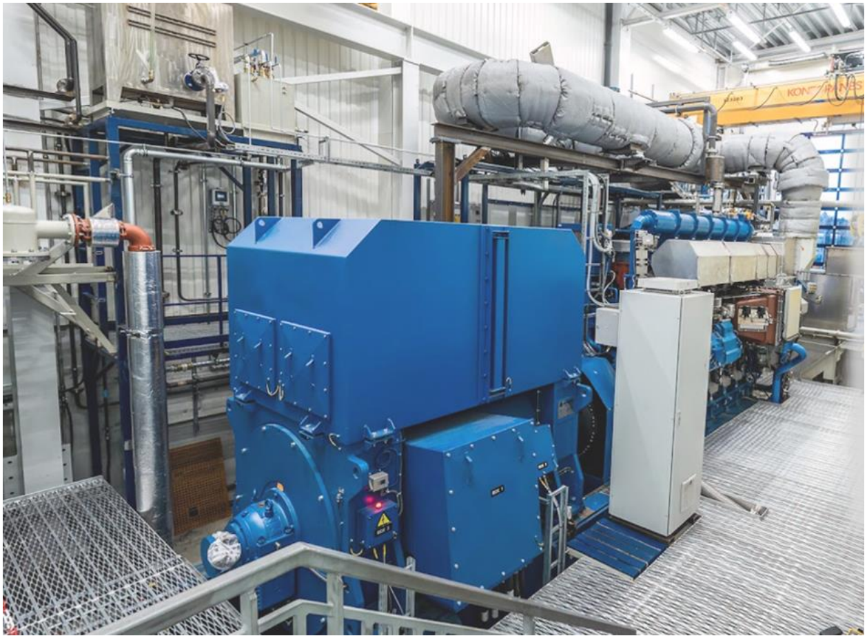
Figur 13 Wärtsilä ammoniakk-motor ved Norwegian Catapult Centre på Stord
