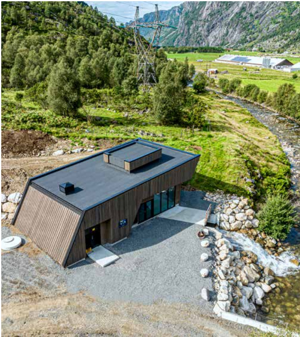
Ørsdalen kraftverk i Bjerkreim er et topp moderne småkraftverk, som er selvstyrt gjennom Dalane Krafts selvutviklede driftssystem – KraftSCADA.
