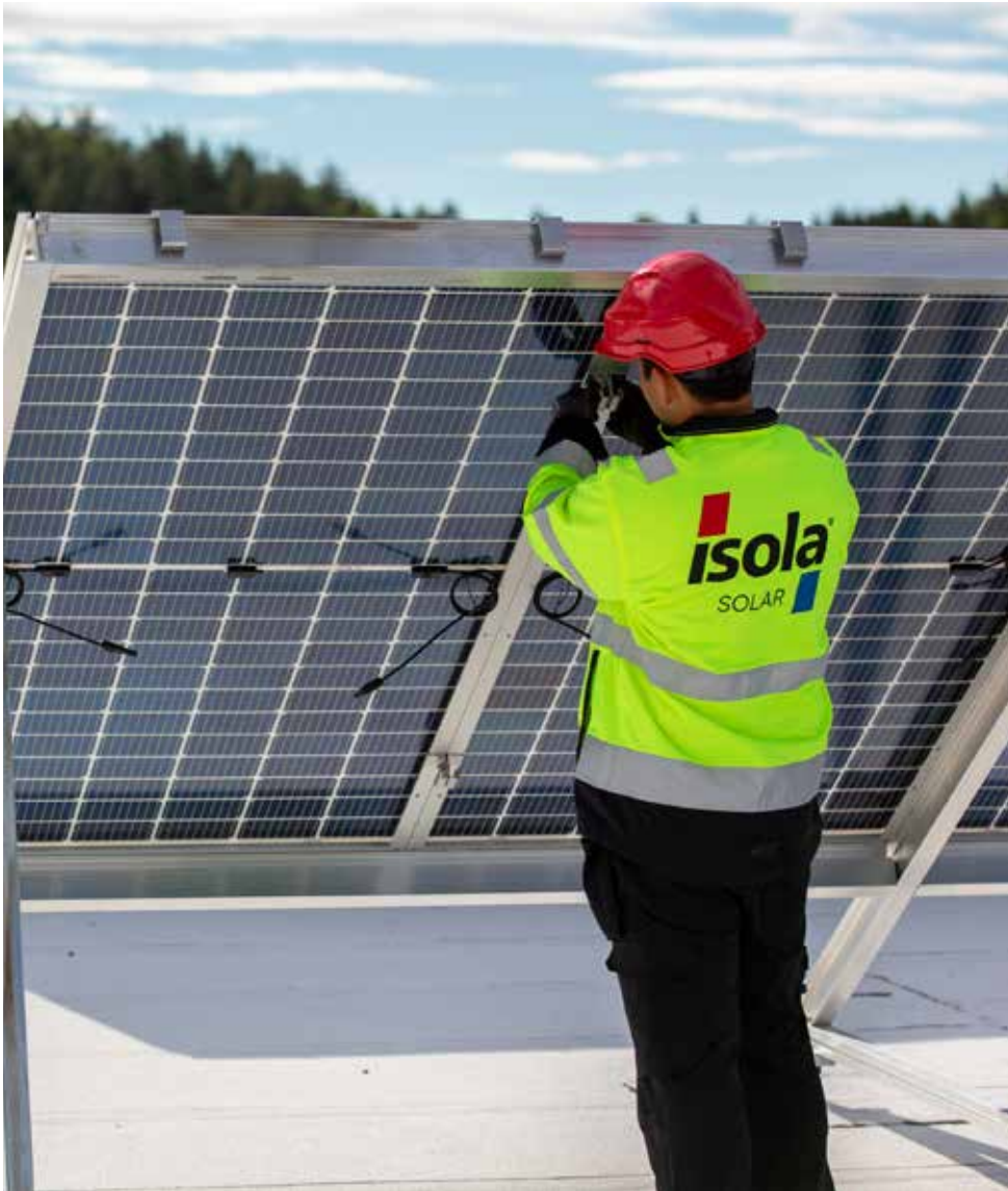
Et bifacial-anlegg henter solinnstråling både fra forsiden og undersiden av panelene, lys som reflekteres fra takets overflate.
